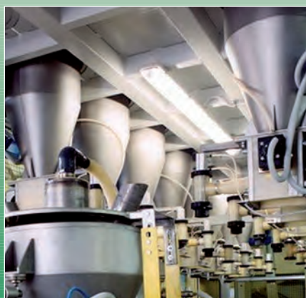
Ensemble de dosage automatisé
