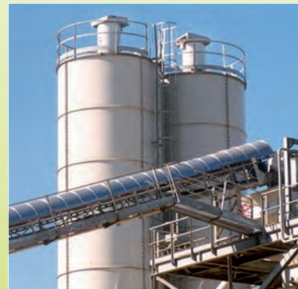
Filtre bridé en extérieur silo
