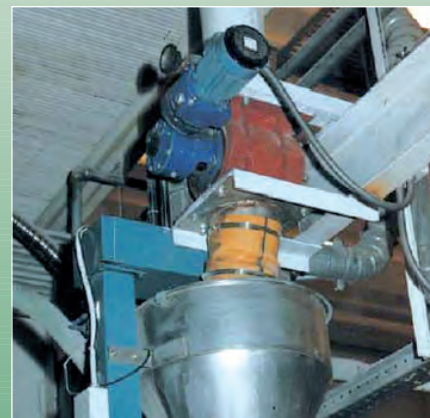
Ecluse de dosage
