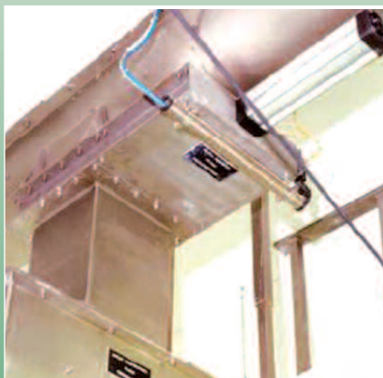
Vanne implantée sous vis de transfert
