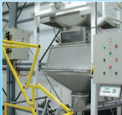
Ensemble implanté sur pesons avec vis de déchargement
