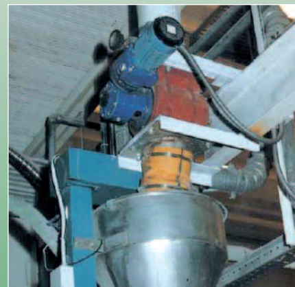
Ecluse de dosage
