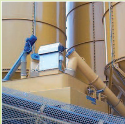
Equilibrage d'une trémie peseuse chargée par vis de transfert
