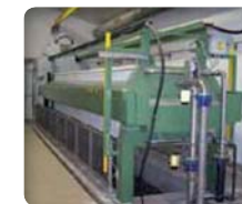
6 Sludge centrifuge
